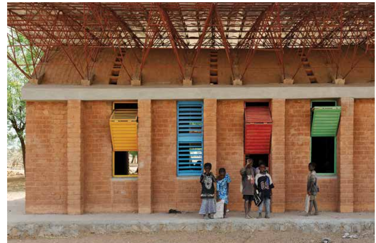
▲ Dogradnja osnovne škole, Gando, Burkina Faso, 2008.
