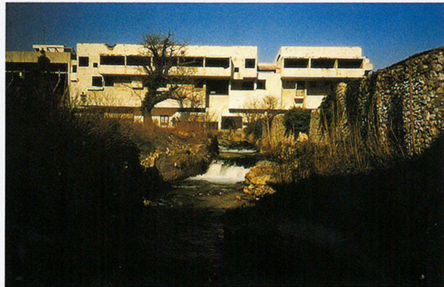
Zlatko Ugljen: Hotel Ruža, Mostar, Bosna i Hercegovina / Bosnia and Herzegovina, 1975. fotografija / photo by Radovan Ivančević
