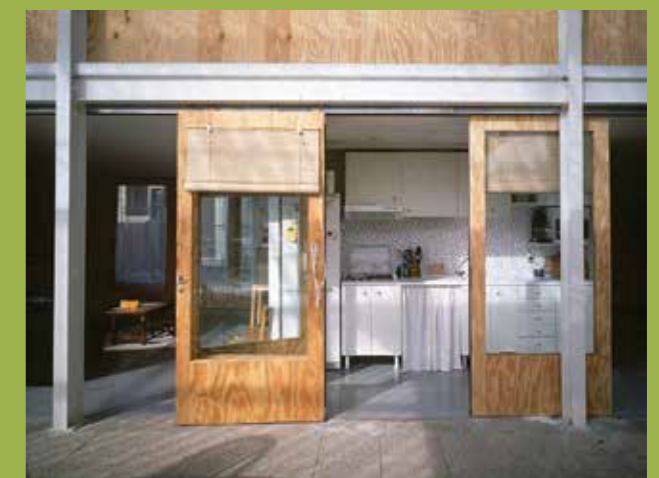
Kuća Latapie / Latapie House, Floirac, Bordeaux, Francuska / France, 1993. fotografija / photo by Philippe Ruault
